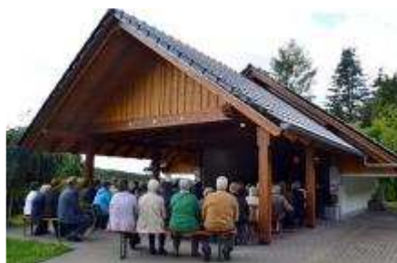
Die Trauerhalle in Michelbach wurde saniert und mit einer großzügigen Vorplatzüberdachung versehen.
